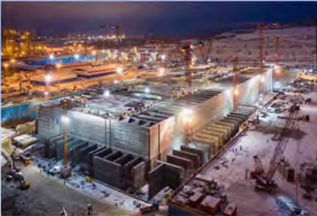
Строительство наплавного завода СПГ в сухом доке в Мурманске
